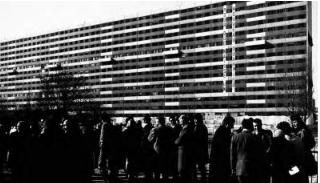
Fig. 2 - Cité des 4 000, démolition de l'immeuble Debussy, 18 février 1986, coll. ministère de l'Égalité des territoires et du logement / ministère de l'Écologie, du développement durable et de l'énergie © Gérard Crossay/MEDDE-MLETR
