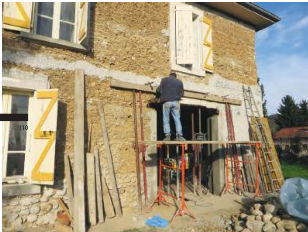
Fig. 4 - Chantier de réhabilitation en cours. Dépose des enduits et création d'ouvertures dans le cadre d'une réhabilitation globale. Le Pin, Isère ©AE&CC-CRAterre-Génis, 2014
